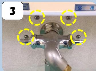
給湯口カバーを固定しているネジを取り外します。
