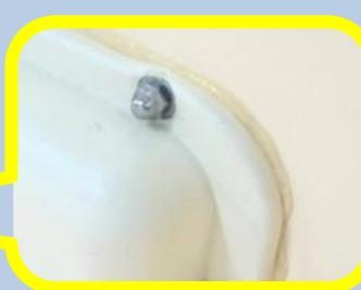
バスコーケ硬化後、給湯口カバーの取り付け時に、はみ出たバスコーケを取り除いてください。
