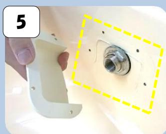
給湯口カバーを取り外し、浴槽に付着している古いバスコーケを取り除きます。
