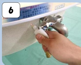
新しい給湯口カバーを取り付ける前に浴槽のネジ穴にバスコーケを塗布します。
