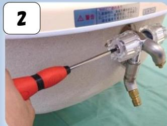
プラスドライバーを使用して自在水栓ハンドルを取り外します。
