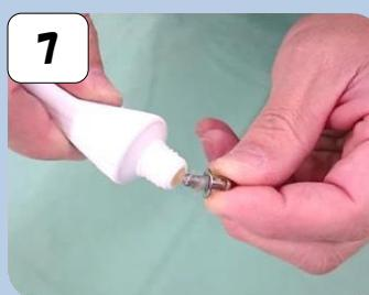
給湯口カバー固定ネジのネジ山にもバスコーケを塗付します。
