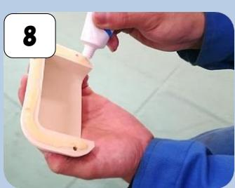
新しい給湯口カバーの取り付け面にバスコーケを塗付します。
