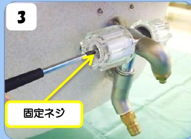
プラスドライバーを使用して、内部の固定ネジを取り外します。
