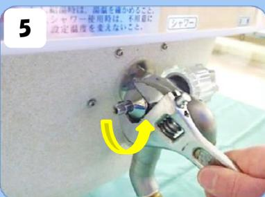
栓棒セットのパッキン押さえをモンキーレンチで取り外します。
